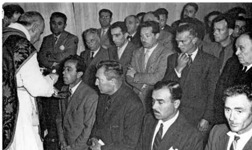
Comunione pasquale agli operai del Cantiere lavori della Ferrovia - a. 1938.
