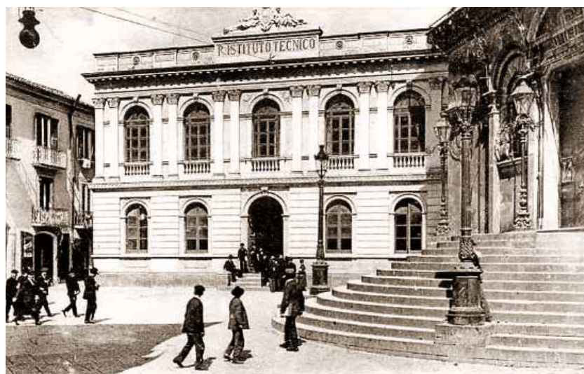
Istituto Tecnico “Pietro Giannone” (un tempo Monastero dell’Annunziata, oggi Istituto di Scuole elementari “G. Pascoli”). Sulla destra in primo piano si vede la vecchia scalinata di accesso alla Cattedrale (oggi modificata).
