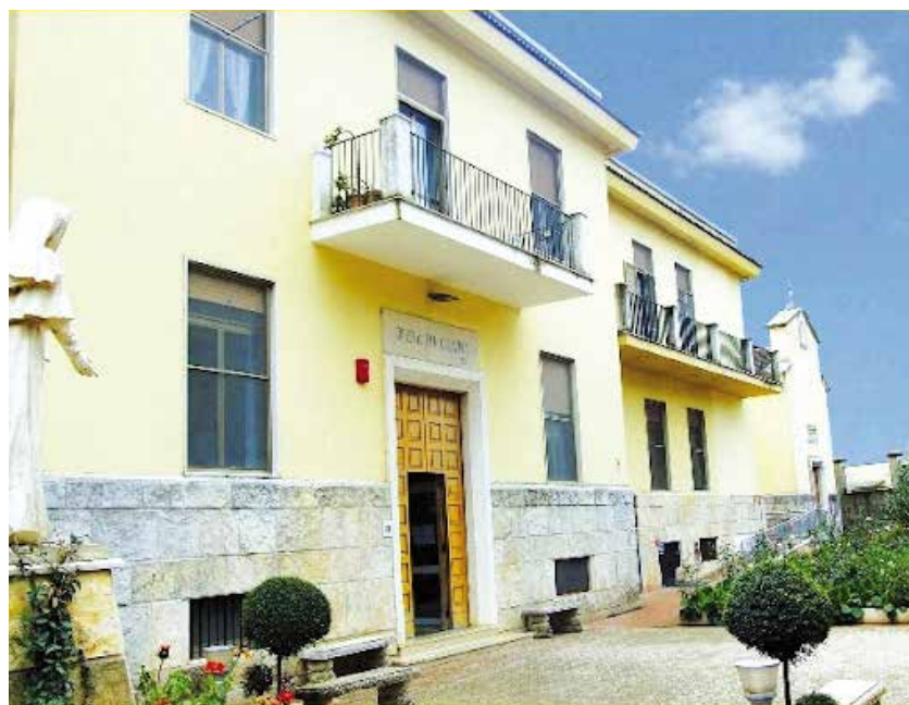
S. Marco in Lamis – Casa della Fondazione Pia "Gravina". Prospetto laterale.
